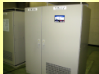
直流電源装置の更新
